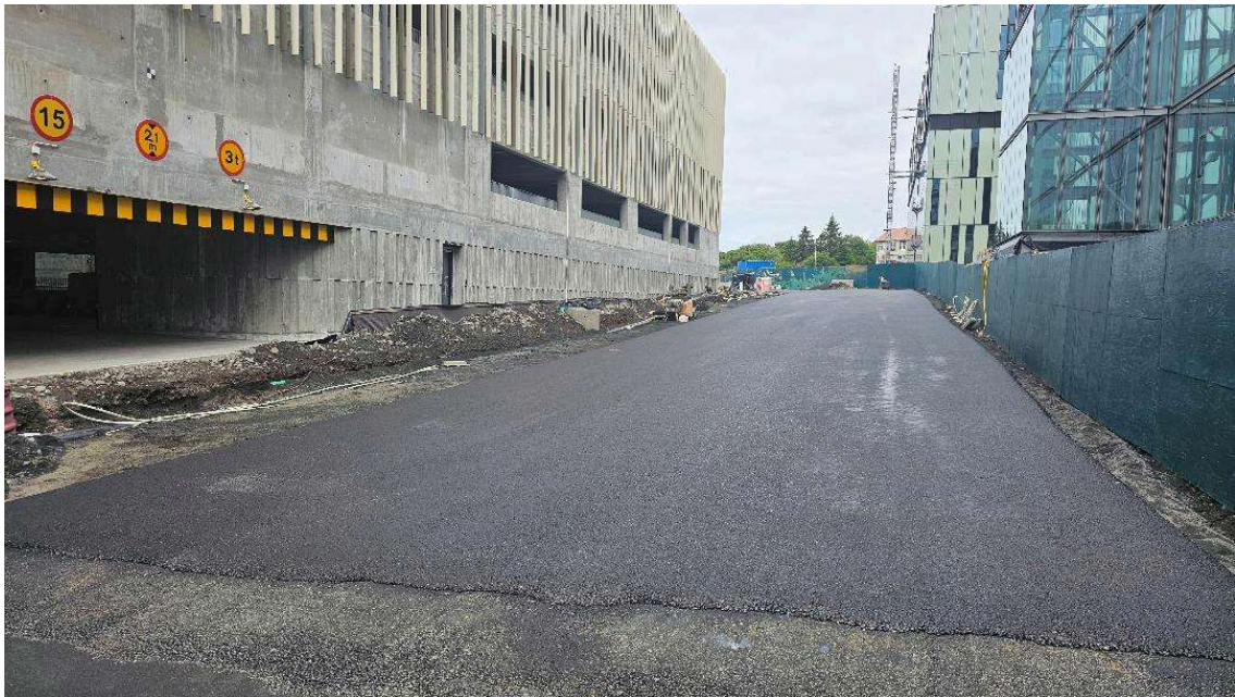
Malbiksframkvæmdir við Hvannargötu.
