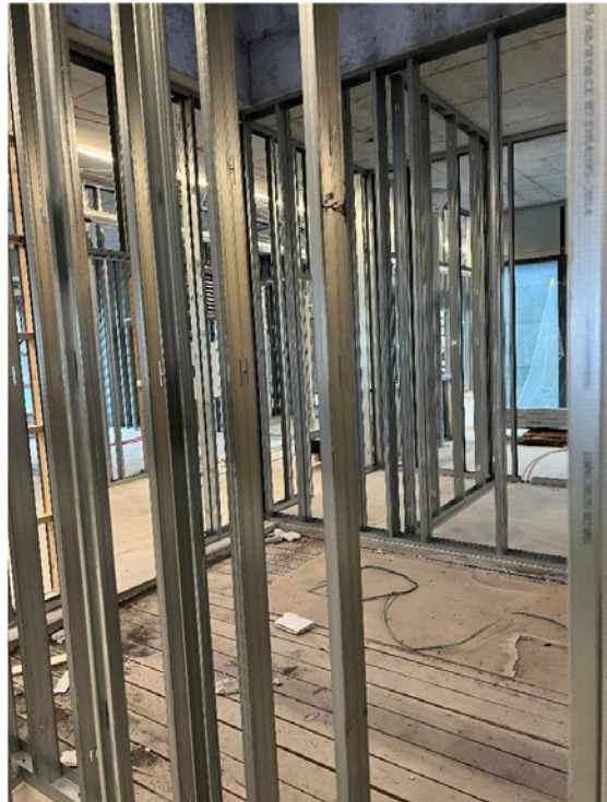
Veggjastoðir á sjöttu hæð í stöng fimm.
