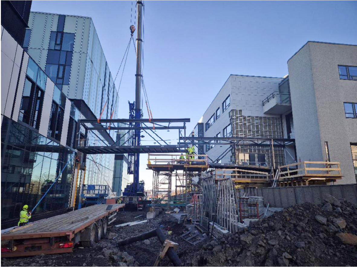
Uppsetning stálvirkis tengibrúar á göngubrúnni.
